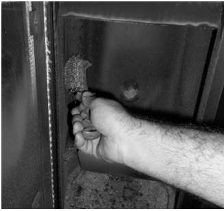
Figura 20 – Limpeza do interior da Salamandra a água
