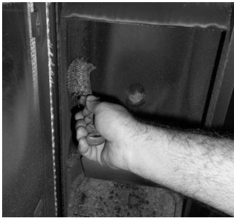
Figura 20 – Limpieza del interior de la Estufa de agua.
