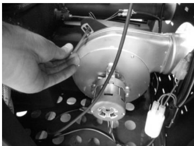
Figura 25 – a) Retirar os parafusos; b) Retirar extractor
