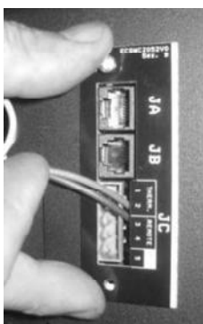
Figura 18 - Instalação do cronotermostato
