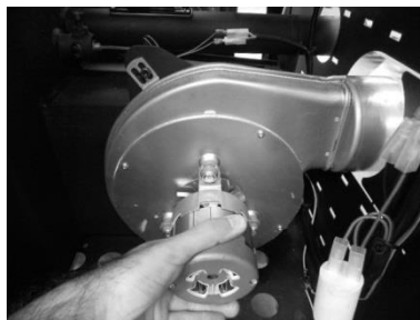
Figura 25 – a) Retirar os parafusos; b) Retirar extractor
