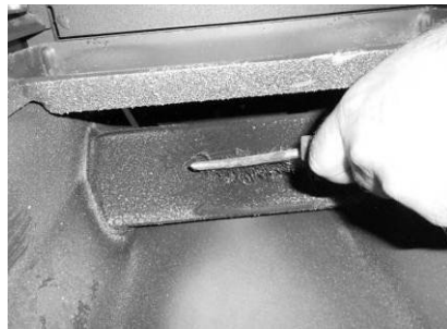
Figura 43 – Limpieza del interior de la estufa de agua
