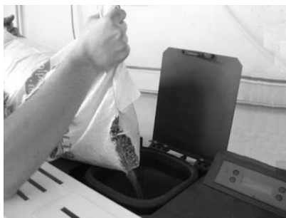
Figura 30 – Reabastecimiento del depósito de pellets
