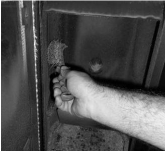
Figura 43 – Limpieza del interior de la estufa de agua
